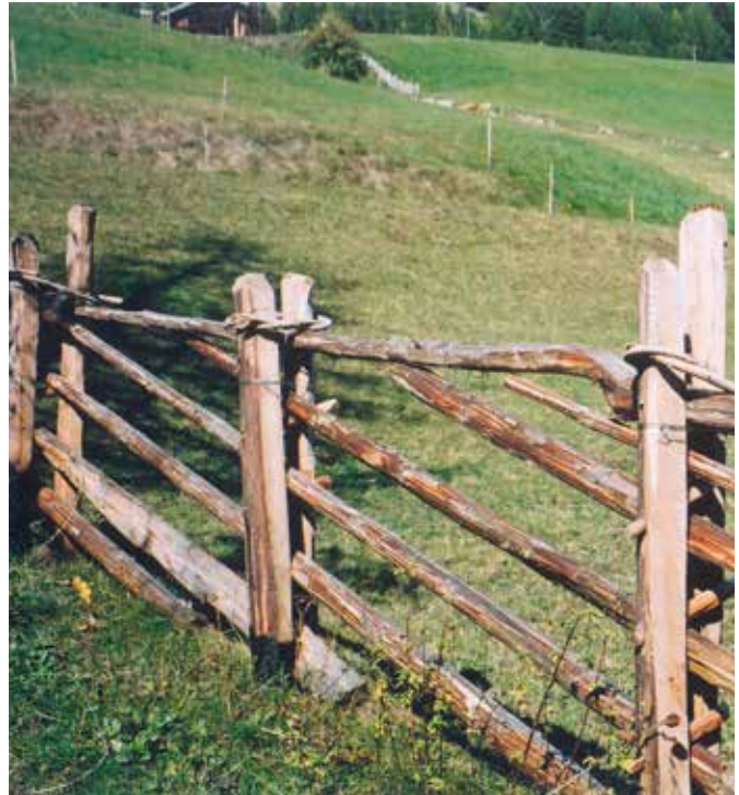
Lattenzaun mit Holznägeln und Holzringen
