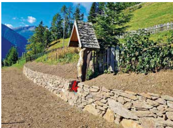
Trockenmauer St. Moritz
