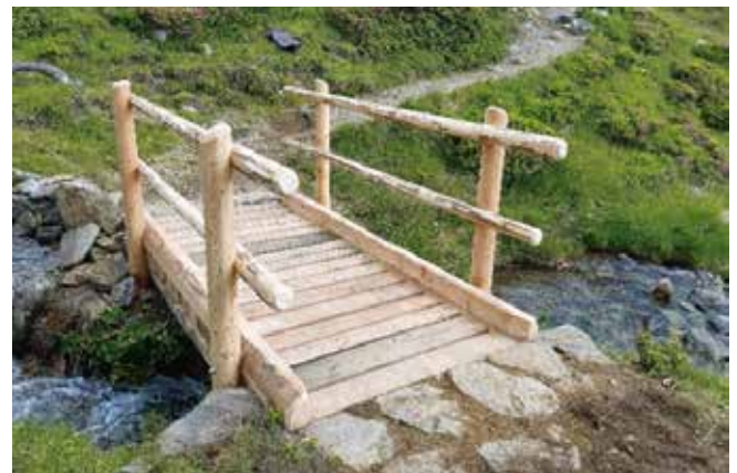
Neue Brücke auf dem Weg zu den Kofelraster Seen
